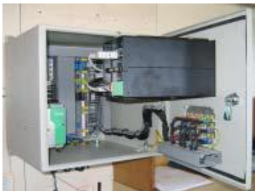
Fot. 2 Wymaganie uziemienia części metalowych, które mogą się znaleźć pod napięciem, zostało wprowadzone konwencją SOLAS 60.
